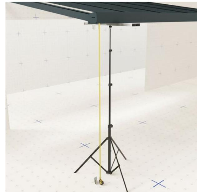
40 Die Regenrinne sollte in Richtung des Fallrohres ein leichtes Gefälle haben, damit das Regenwasser an diese Seite läuft und abfließen kann. Hierbei ist ein Höhenunterschied von 1-2 cm vollkommen ausreichend.
